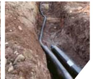
Wiederverwendung als Füllmaterial für Fernwärmelleitungen
