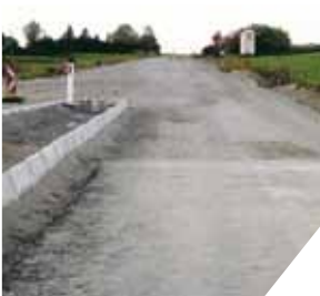
Réutilisation dans les couches portantes non liées
