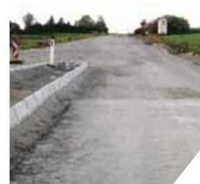
Réutilisation dans les couches portantes non liées
